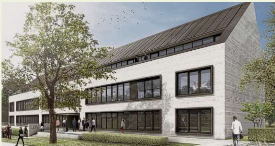
Mit dem Umzug in den Neubau in der Egilolfstraße in Stuttgart-Hohenheim, in direkter Nachbarschaft zur Universität Hohenheim, stellt die Buchstelle die Weichen für die Zukunft. | Foto: Architekten Schlude, Stuttgart
